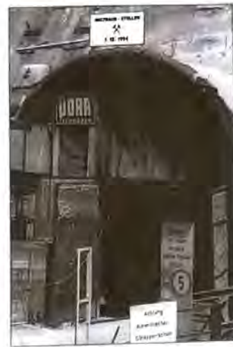
Einsatz für steirische Zukunftsprojekte: Der „Waltraud-Stollen“ als Grundlage für den Semmering-Basistunnel
